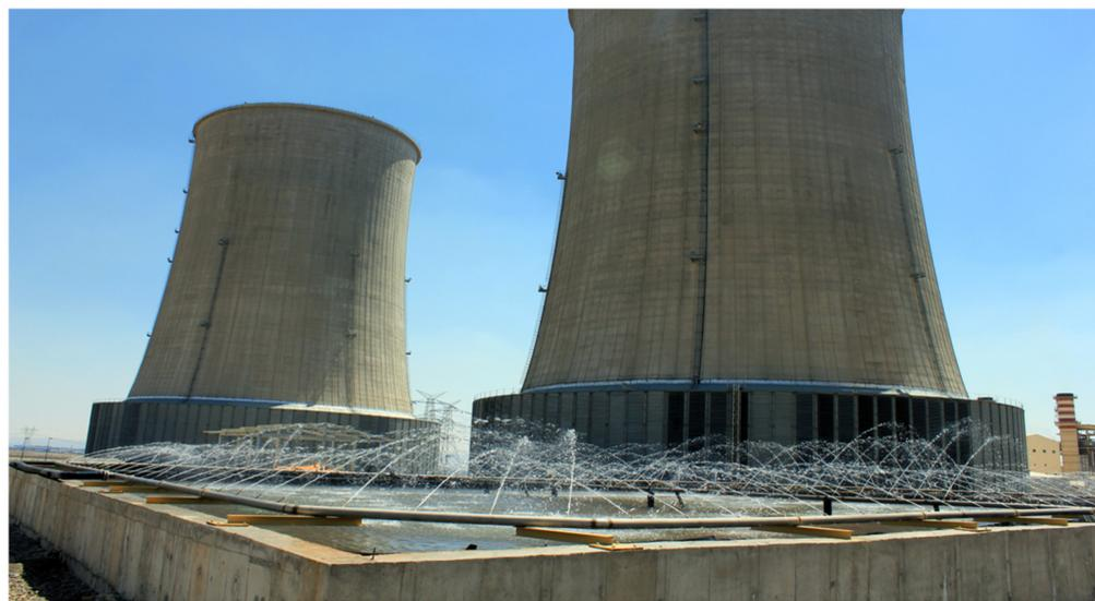
پس از اجرای عملیات انتقال آب بلودان ها به مخزن کلین درین، مرحله دوم طرح بازیافت و استفاده مجدد از آب خروجی از بلودان ها با ساخت استخر بازیافت به انجام رسید. با توجه به دمای بالای آب جمع آوری شده مسیر بلودان ها که در مخزن کلین درین نگهداری می شود و با توجه به میزان بالای آهن موجود در این آب استفاده مجدد از این آب بدون بازیافت ممکن نمی باشد که این مهم با ساخت این استخر محقق گردیده است.
